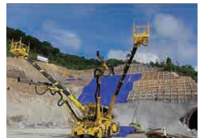
ベトナム国道1号プロジェクト (Ca Passトンネル:2016年7月貫通)
